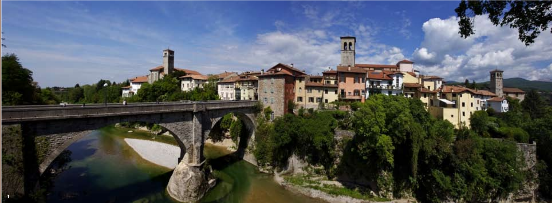
1 Veduta di Cividale dalla forra del Natisone.
